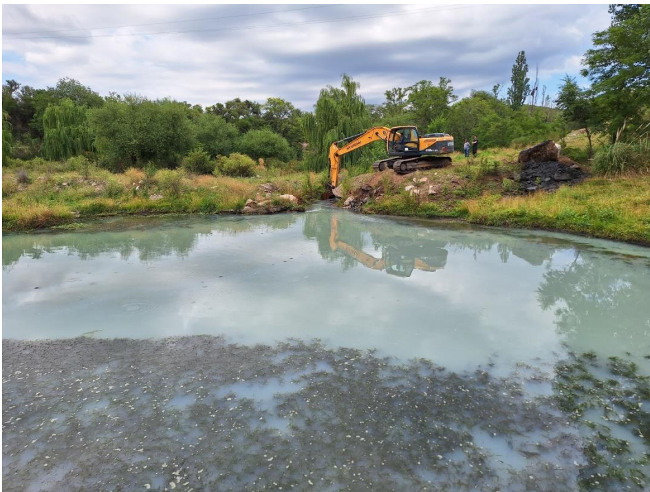
Situación inicial al comienzo de los trabajos, generando la salida a los volúmenes estancandos
